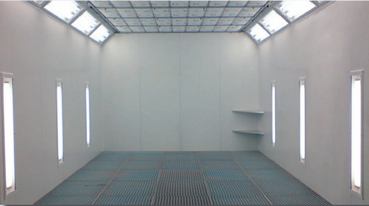
Θάλαμος με κάτω φώτα σε οριζοντια διάταξη Δάπεδο με σχάρα και φίλτρο paint-stop μόνο στα σημεία αναρρόφησης.
