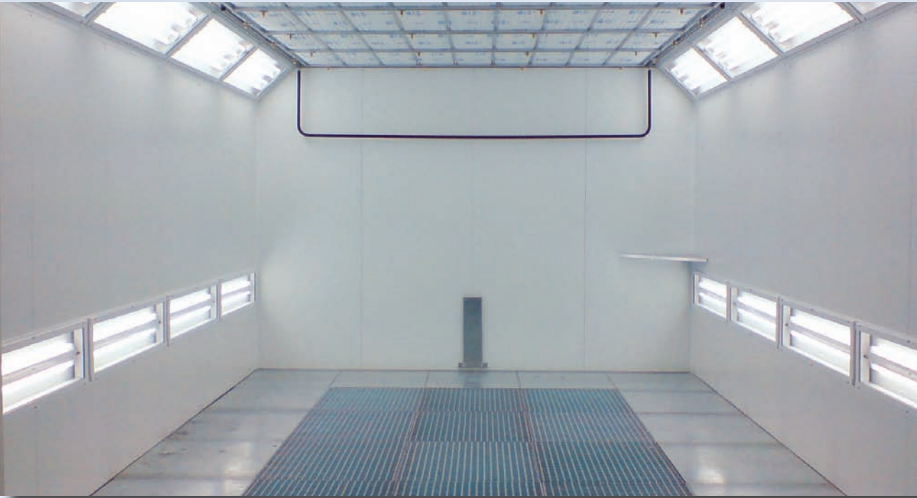
Θάλαμος με κάτω φώτα σε οριζοντια διάταξη Δάπεδο με σχάρα και φίλτρο paint-stop μόνο στα σημεία αναρρόφησης.
