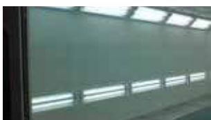
Φωτισμός στα πάνελ σε οριζόντια διάταξη με LED φωτιστικά
